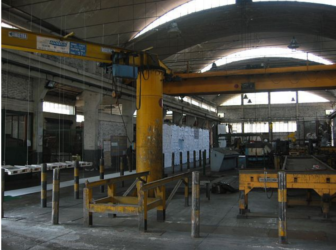
Fig. 23 Interno della SGL Carbon
