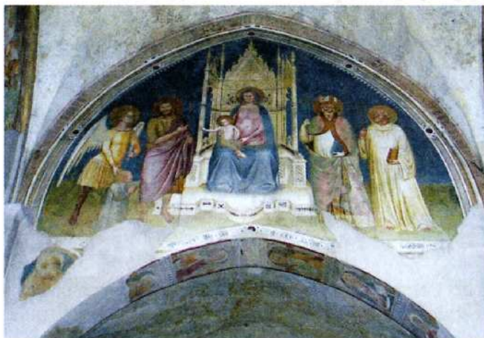
Immagine 9 – Abbazia di Viboldone, San Giuliano Milanese (MI). Interno della chiesa. Affresco raffigurante la Madonna in trono . La presenza di una zona a rischio non è evidente, ma può essere identificata grazie alla ripresa termografica.
