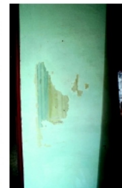
Fig. C16, C17 Saggi di scoperta sulle superfici imbiancate della stessa stanza
