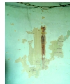
Fig. C16, C17 Saggi di scoperta sulle superfici imbiancate della stessa stanza
