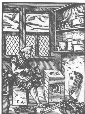
Fonditore in un'incisione dal "Libro dei Lavori" (Germania, 1568)
